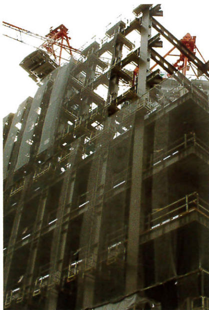
鉄骨建方に使用
