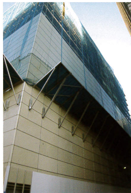
防音パネルの養生に使用
